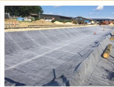
Mise en place de la bâche pour l'étanchéité des bassins principaux de 35 x 5 m de surface
